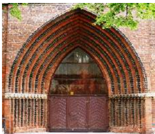
Westportal mit glasierten Backsteinen
